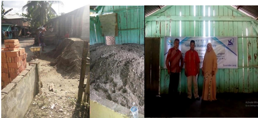
Gambar 22. Material, Penimbunan dan Hasil Pengerjaan yang sudah di Selesaikan
