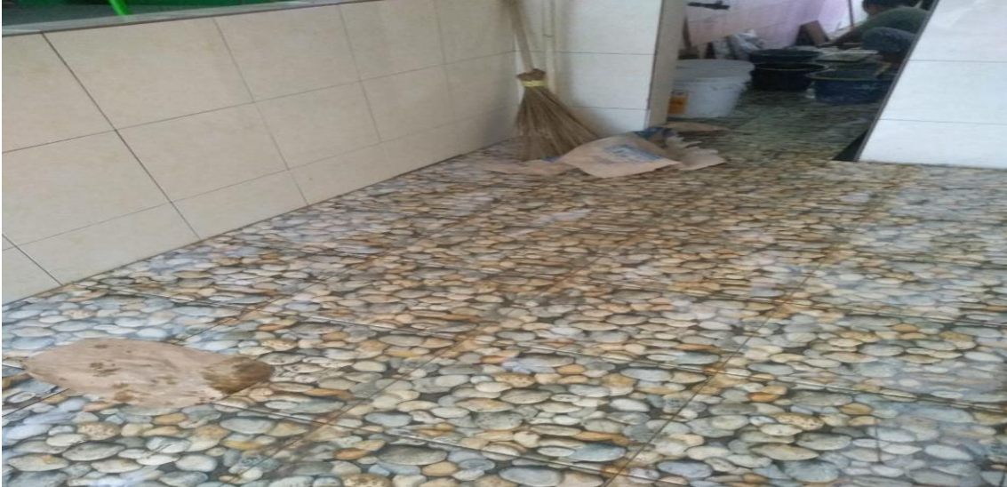
Gambar 3.1. Lantai dan dinding kamar mandi yang telah direnovasi Sumber: dokumen pribadi
